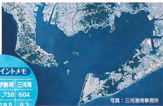
写真：三河港湾事務所
