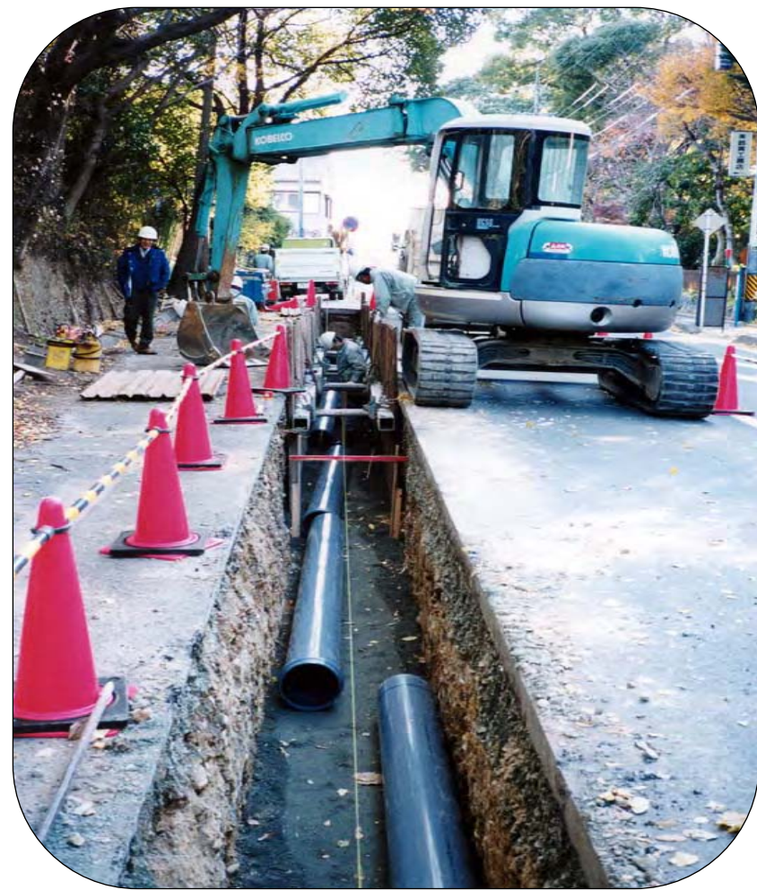
下水道の整備
